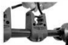
Montarea curelelor de susținere
